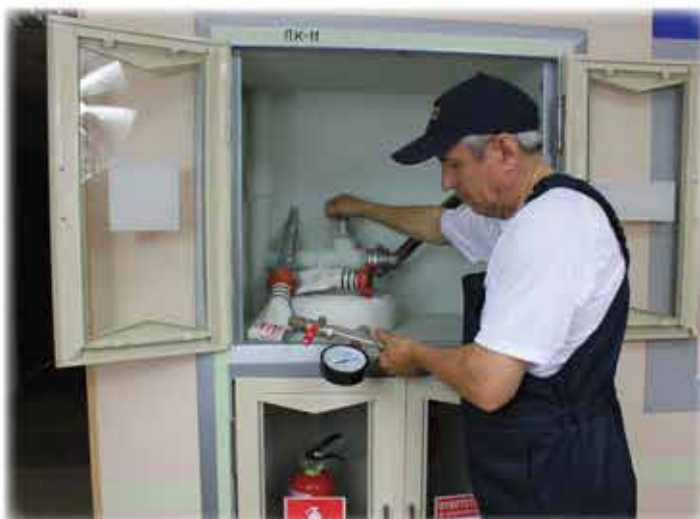
Испытание внутреннего противопожарного водопровода. На фото: Рауфф Фаткулович Хурматулин
